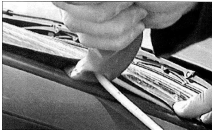
Figura 4.6. Aplicación de burlete de junquillos.
