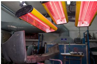
(Acelerar el proceso de curado mediante infrarrojos si se considera necesario).
