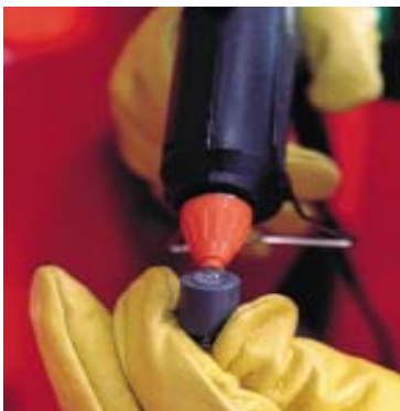
(Aplicación del adhesivo)
