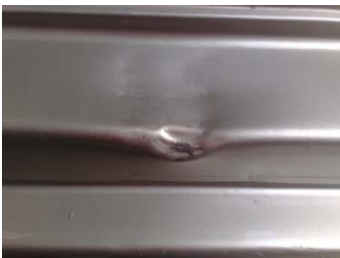
(Inspección visual y táctil del daño)
