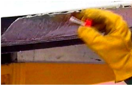
(Aplicación del pasivador)
