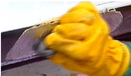
(Extender el estaño con un estropajo)
