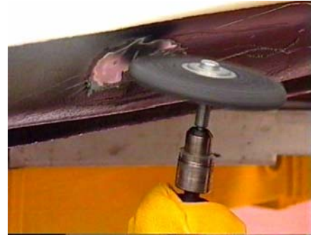
(Lijado de la superficie a trabajar)
