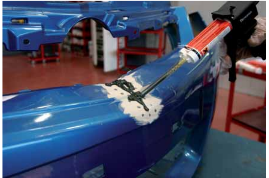
▶ Reparación de plástico mediante adhesivo
