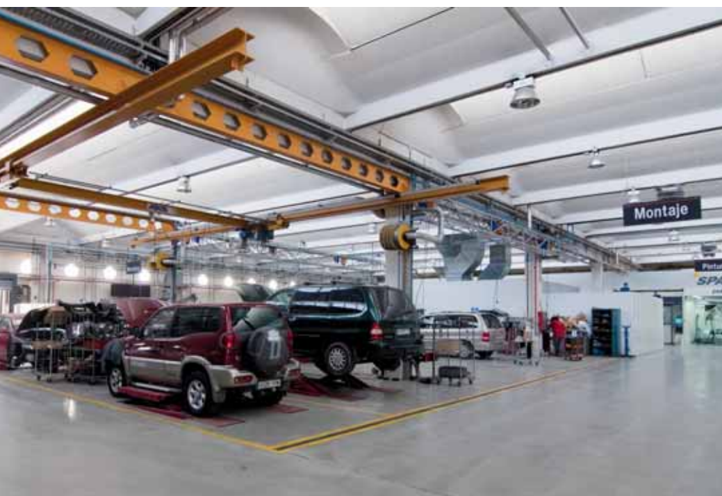
▮ Puestos en un taller de reparación
