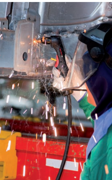
▶ Accesibilidad para la ejecución de todo tipo de cortes
