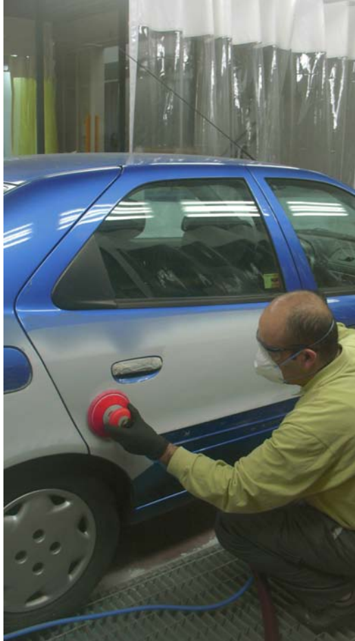
▶ Lijado del aparejo mediante sistema tradicional
