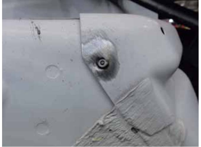
► Punto calado TIG en chapa de acero
