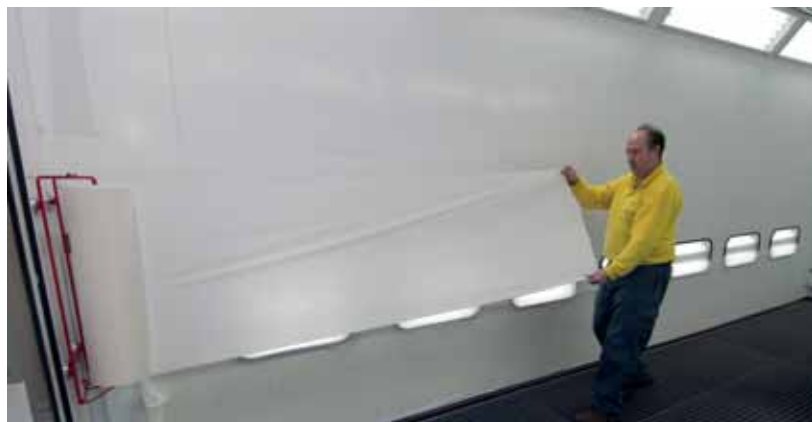
► Colocación de protección textil en las paredes de la cabina
