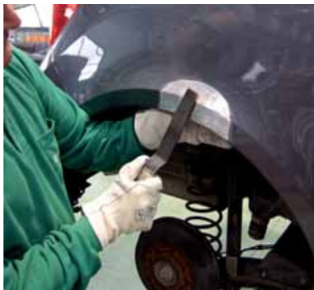
▶ Reparación con acceso
