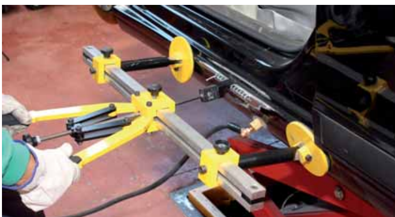
Reparación de un estribo
