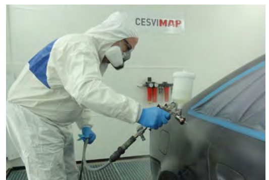
► Aplicación de la base agua
