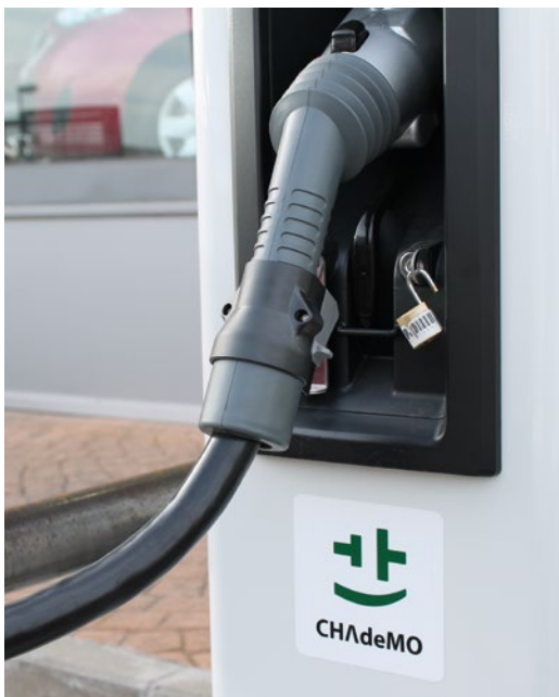
► Poste de carga Chademo
