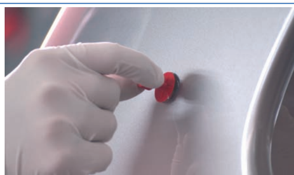
4 Pegar la ventosa en la depresión del daño (en el centro de ella).
