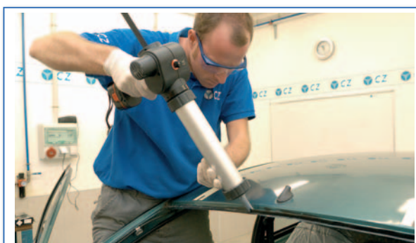
9 Aplicación del cordón de adhesivo (sobre marco o luna).
