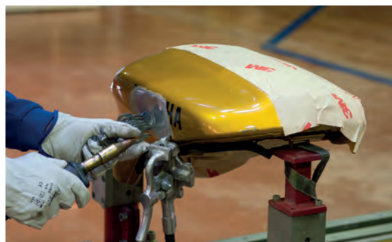
Soldadura de arandelas en la zona deformada.
