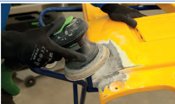
9 Lijar el material sobrante, dando forma a la superficie exterior.
