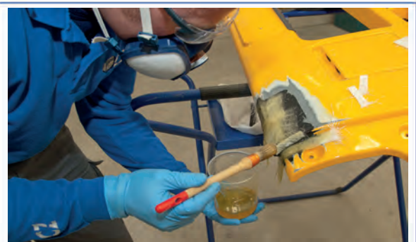
8 Rellenar la superficie dañado con capas alternas de resina y fibra.
