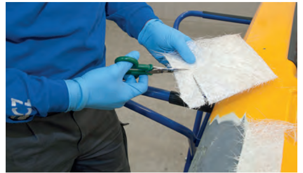
6 Recortar las capas de fibra de vidrio a añadir.
