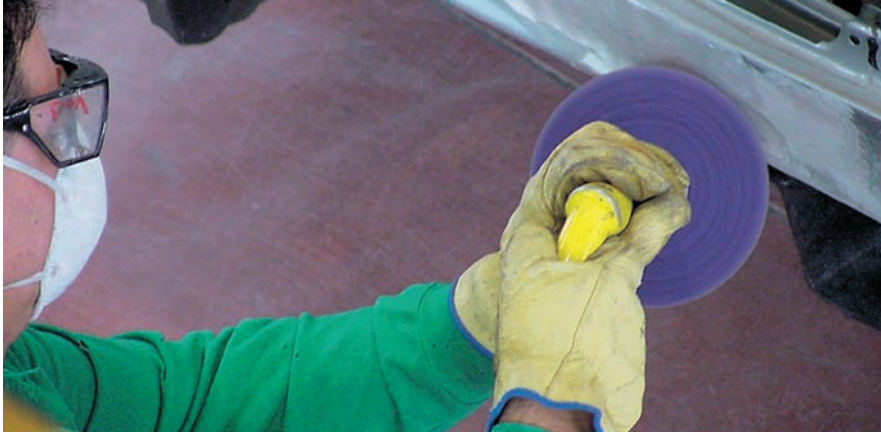
Eliminación de la pintura
