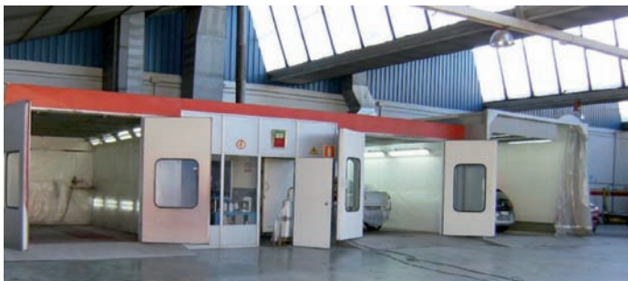
▲ Zona de pintura
