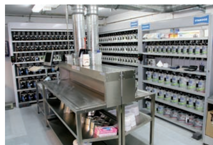
Box de pintura de las nuevas instalaciones.
