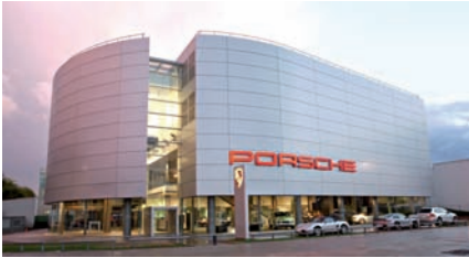
Fachada del Centro Porsche Barcelona.
