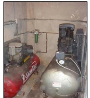
\* **El filtro purificador de aire** retiene todas las partículas de aire comprimido y la humedad acumulada en el interior del compresor, para que no discurra por la manguera hasta los receptores. El aire comprimido que llega a las pistolas de pintado y los aerógrafos, debe estar exento de partículas solidas, grasas o aceites, así como de condensación de agua, ya que producirían defectos en la capa de pintura.
