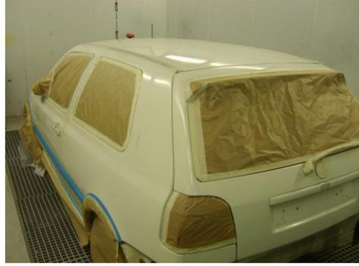
**3.4 Técnicas y Procesos de enmascarado para la aplicación de pintura a piezas del vehículo con pintado completo o aplicando la técnica de difuminado.**
