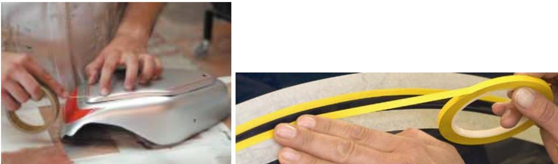
Los trabajos de pintura que comportan varios colores o diseños exigen un trabajo de alta precisión, un enmascarado meticuloso y bordes precisos.
