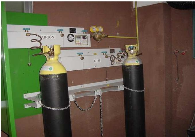
**Manorreductor/ caudalímetro:** es el aparato que tiene como misión reducir la presión de almacenamiento a la presión necesaria para la soldadura. La regulación de caudal es muy importante porque depende la protección de la fusión.
