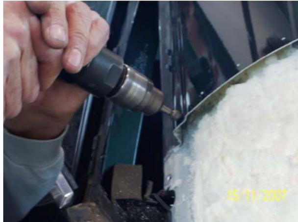
Y para finalizar esta parte del proceso, se colocan unos gatillos de sujeción en el empalme, para poder presentar la aleta y hacerle sus agujeros, para ello la aleta debe de estar confrontada y sujeta con mordazas.
