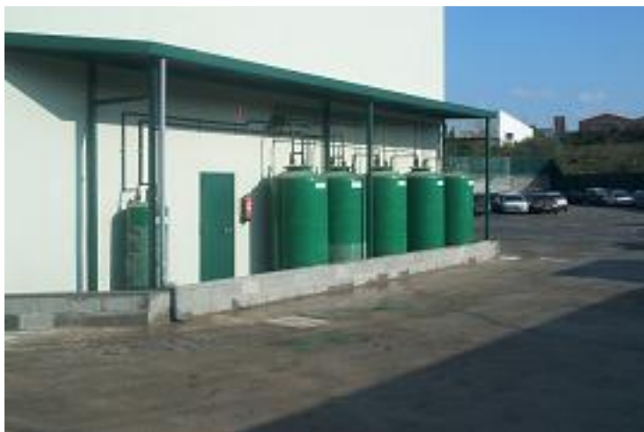
Ejemplo de un CAT en el cual observamos los bidones para acumular los fluidos (gasolina, aceite, etc.) de los vehículos que se extraen antes de empezar con el reciclado del vehículo.
