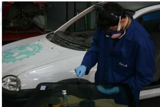
3.- Después de haber secado la imprimación y haber esperado el tiempo correspondiente a su evaporación, se aplica el cordón de adhesivo
