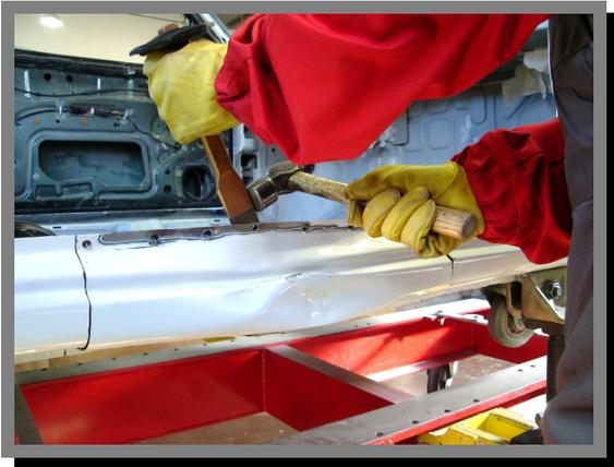
14. Soltar las pestañas del estribo de la carrocería con la ayuda de un cincel de corte lateral. No dañar la chapa soporte.
