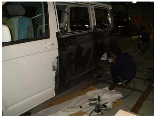
Para finalizar el trabajo de chapa se soldó la nueva aleta y la nueva columna.
