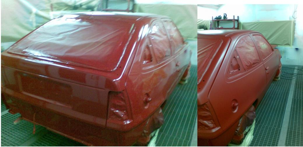
**Después de un largo proceso de enmascarado el coche está listo para ser pintado. En esta foto aparece el coche ya terminado de pintar y con el enmascarado, después de esto se procede a quitar el enmascarado y comprobar que no haya pulverizado en ninguna parte si es así limpiarlo.**
