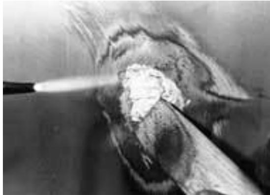
10. En frío se elimina el exceso de material con una P120:
