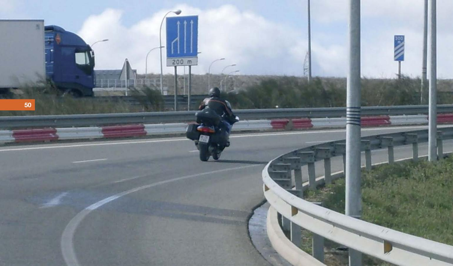
*El material compuesto de la valla inferior absorbe la energía del choque y redirecciona el cuerpo del accidentado, evitando su vuelta a la calzada y eliminando el riesgo de ser atropellado por otro vehículo.*
