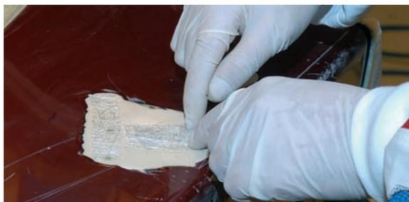
*Reparación de grieta en material compuesto.*
